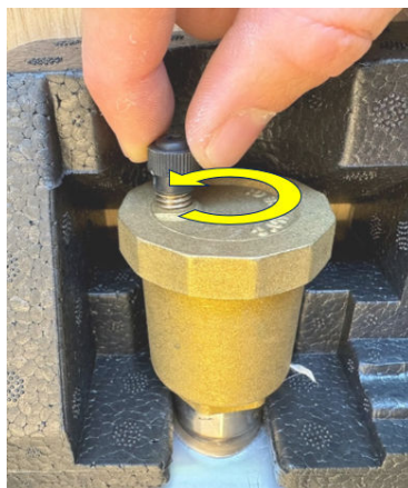
Het openen van de dop van de ontluchtingsventiel
