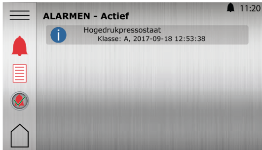
Fig. 2: Voorbeeld van alarmen
