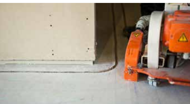
Ons freestool is gekoppeld aan een 2-motorige stofzuiger en een vuilafscheider. Hierdoor kunnen wij 100% stofvrij werken.
