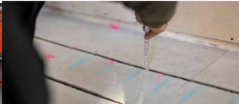
Elke uitgefreesde kring krijgt een controle van diepte en breedte. Zo kunnen we bevestigen dat de buis netjes in de sleuven past.
