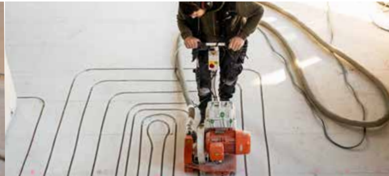
Elke kring frezen we volgens een door ons ontworpen schema. Zo weet je op voorhand hoe het patroon er zal uitzien.
